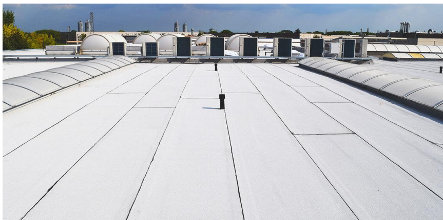
Figura 9 Immagine tetto con guaina tipo cool roof
